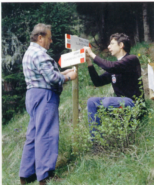
Posa di tabelle segnavia sul sentiero 325 (Palù del Fersina-Lago di Erdemolo) durante il 5° Incontro di aggiornamento e formazione per la manutenzione dei sentieri
